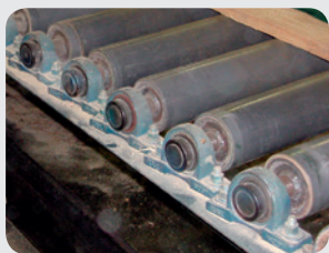
Ρουλεμάν ιμάντα με υπερθέρμανση
